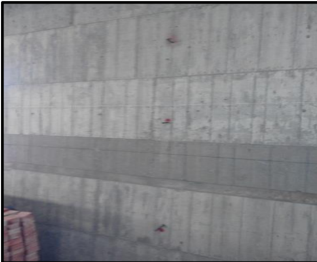
1.與RC牆植筋加強固定
