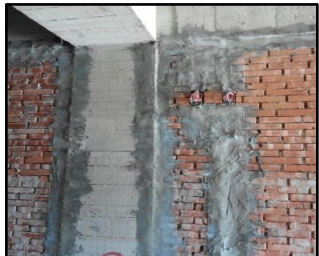
4.牆面配管後填飽漿再用抗裂網加強
