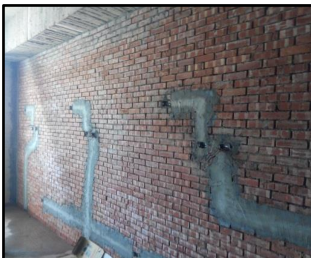
5.牆面配管後填飽漿再用抗裂網加強
