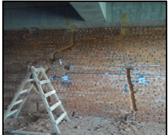
2.牆面管線先切割再打溝
