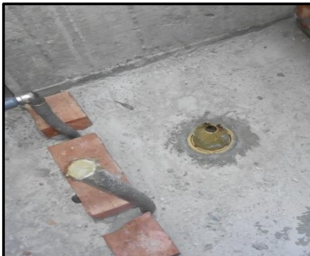
3.管道間內地面排水管保護
