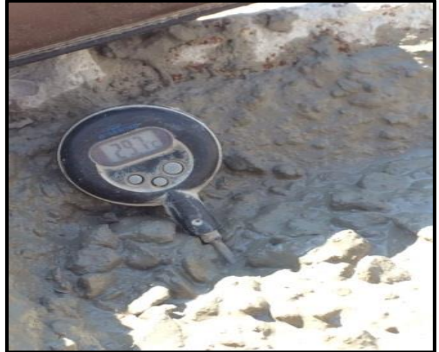
2.混凝土表面溫度檢測
