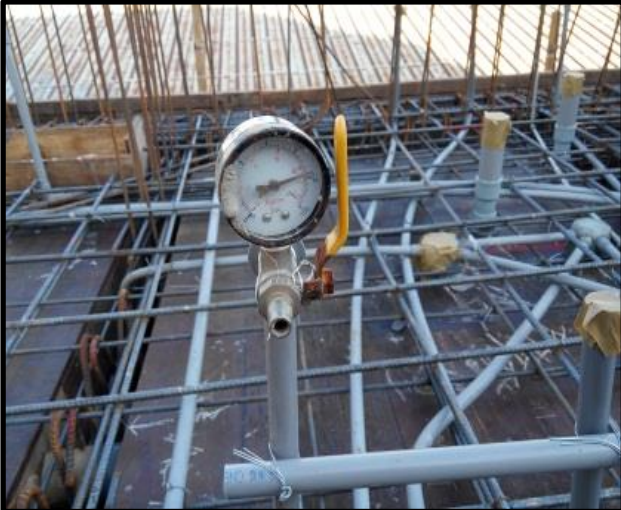
1.給水管試壓檢測
