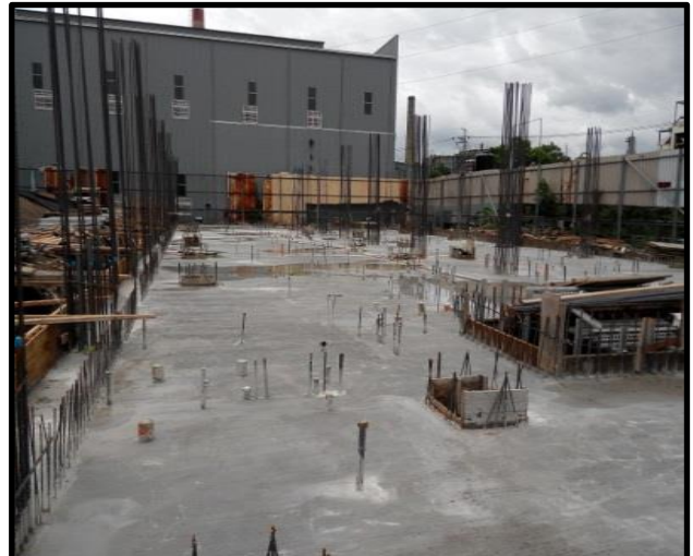
4.澆置完成後養護
